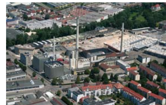
Moderne Technik: Das Biomasseheizkraftwerk der FUG
