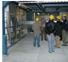
Im Heizkraftwerk: Die SpaZz-Leser
