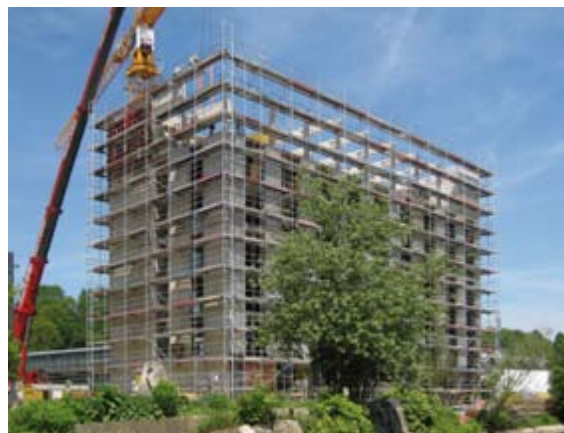
Vier-Sterne-Hotels in der Friedrichsau: Der Rohbau steht schon
