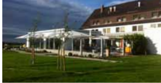
Weitblicke: Die neugebaute Terrasse mit Münster-Panoramansicht
