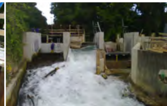
Für den City-Bahnhof Ulm musste die Kleine Blau umgeleitet werden // Ein neuer, 160 Meter langer Kanal entlastet die Blau bei Hochwasser
