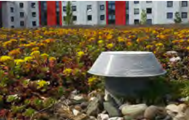
Ein grünes Dach // Sieht schön aus und spart Abwassergebühren
